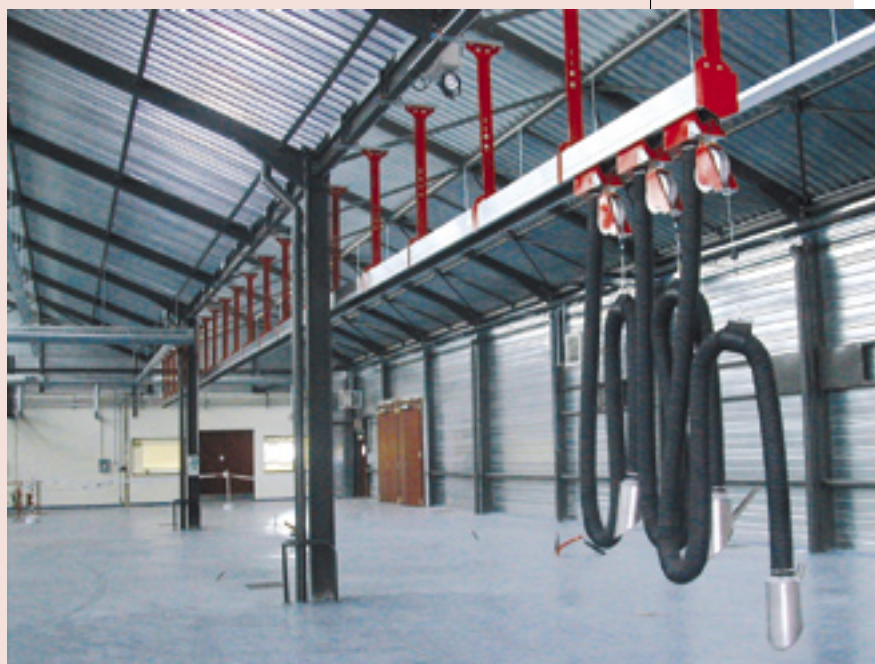
Système d'aspiration des gaz d'échappement sur rail ►
