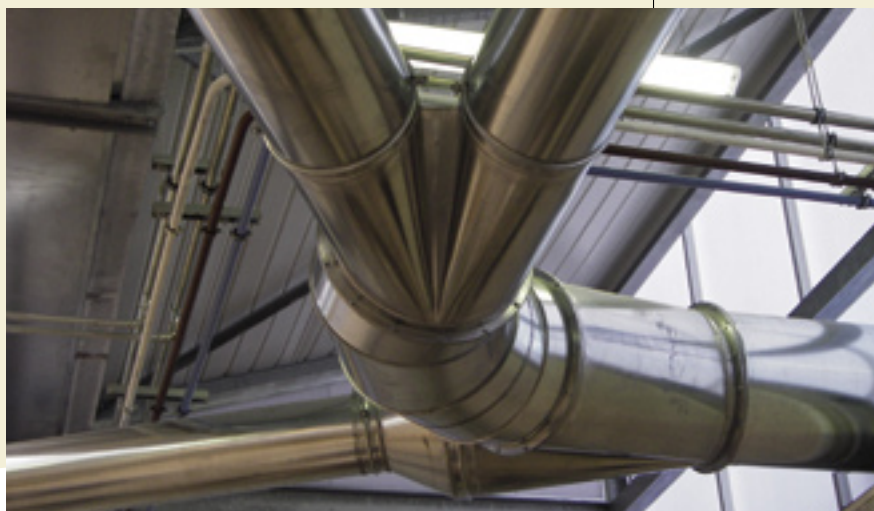
Système d'aspiration sur une fraiseuse à bois ▶
