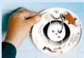
Установить и подсоединить модуль
