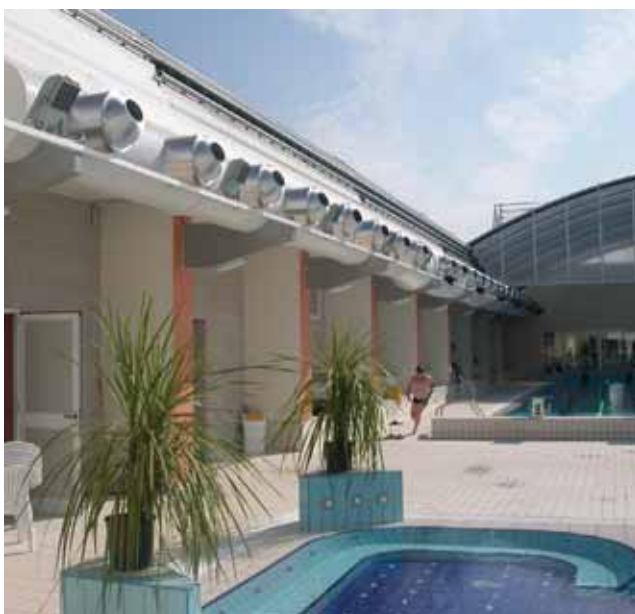
Установка диффузоров Perlys® снаружи в водно-спортивном центре.
