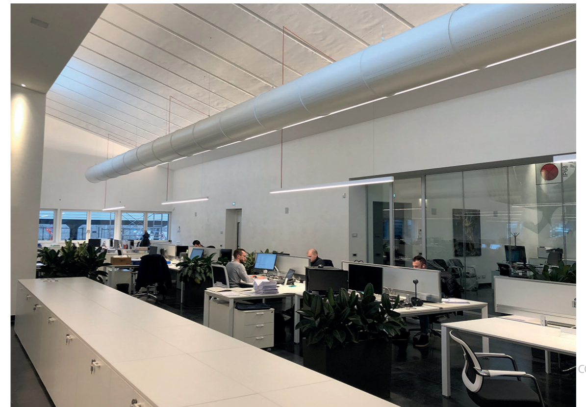
Installation en open space
