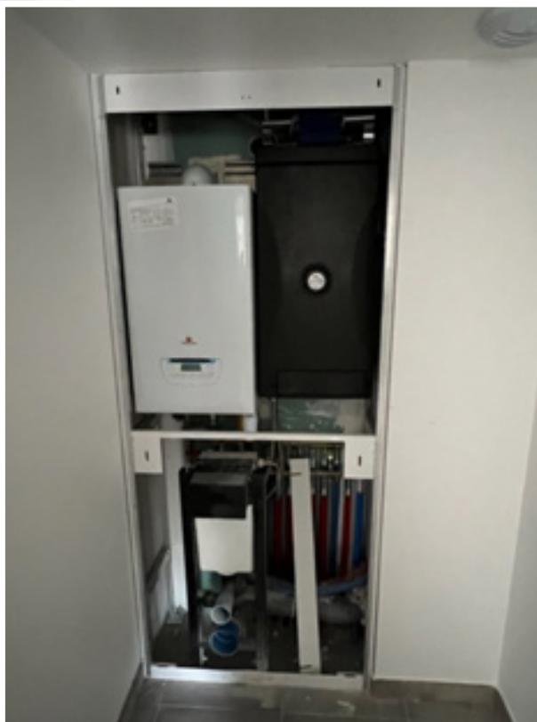
Intégration du système dans le châssis fourni
