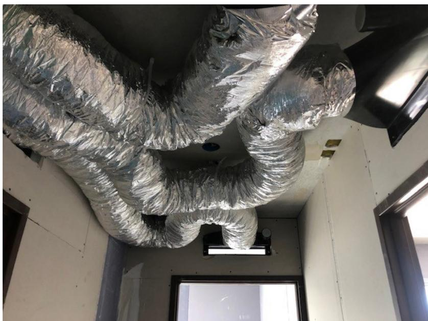
Pose des gaines en «S» pour un confort thermique et acoustique optimal
